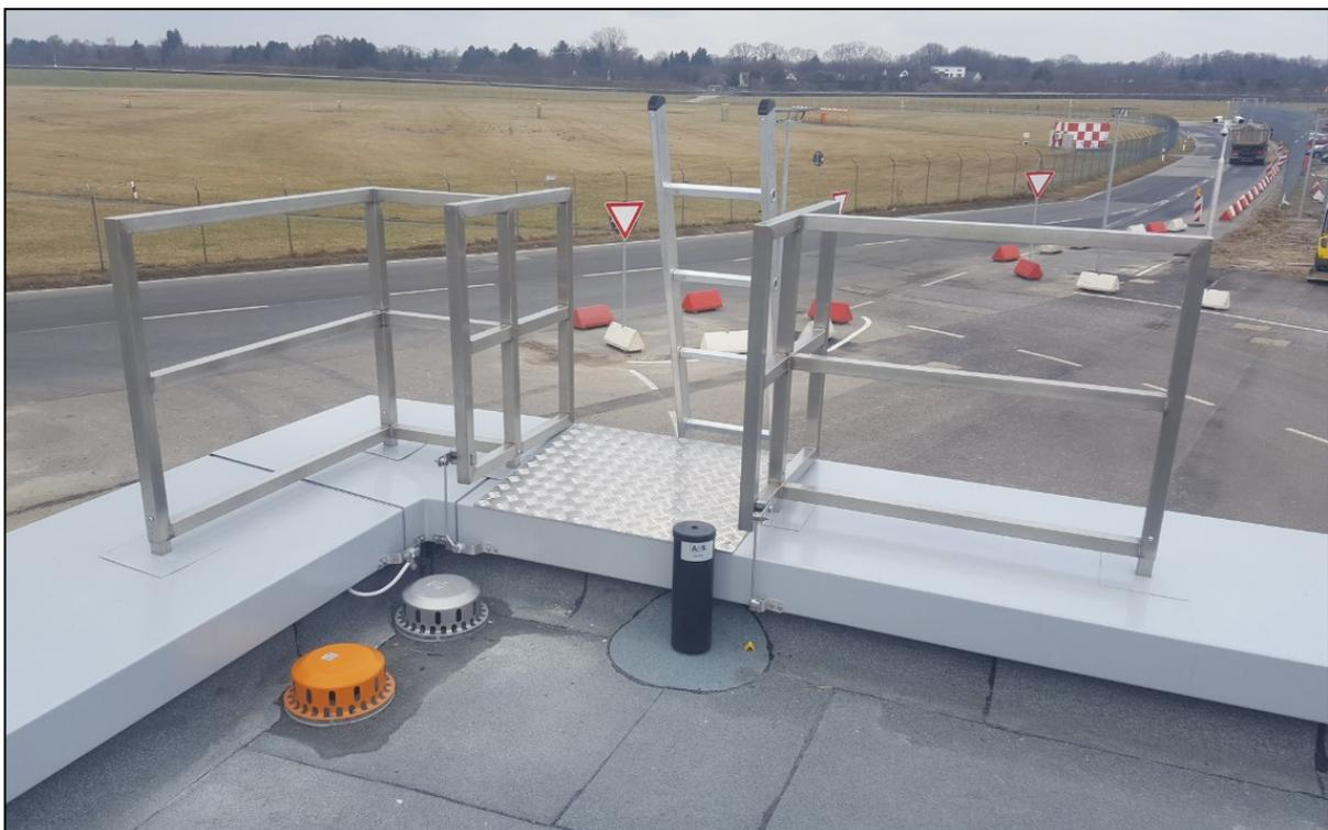
Abbildung: Muster für eine Dachaufstieg Absicherung
