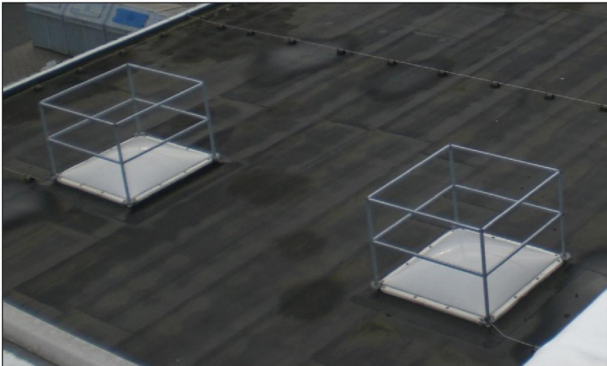
Abbildung: Absicherung von Lichtkuppeln mit einem Geländer auf dem Dach
