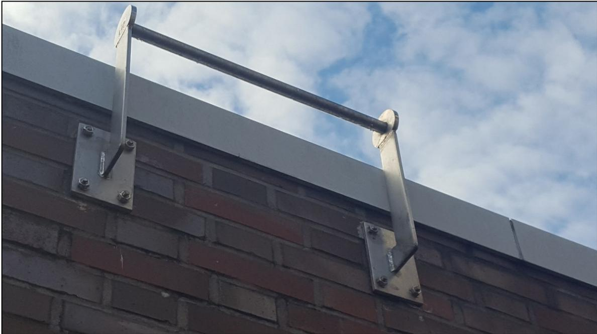
Abbildung: Muster für Anschlagpunkt einer Leiter
