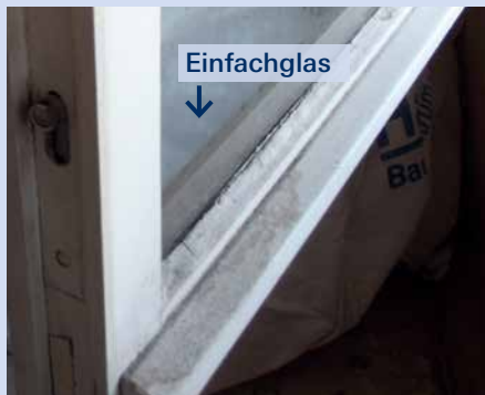
Bild 1: Fenster mit Einfachglas
