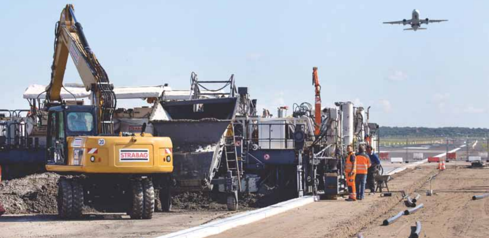
Die größte Baumaßnahme der letzten Jahre auf einer Betriebsfläche am Hamburg Airport – Präzisionsarbeit auf der Piste 05/23: Über 30 Firmen und Institutionen arbeiteten Hand in Hand, um einen straffen Zeitplan einzuhalten
