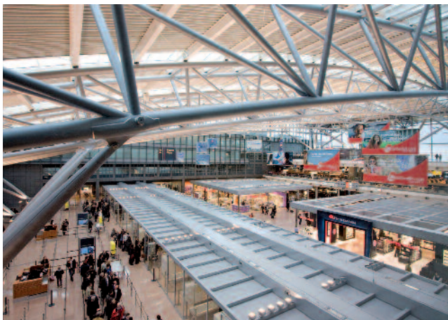
Großzügig und hell: die Airport Plaza
